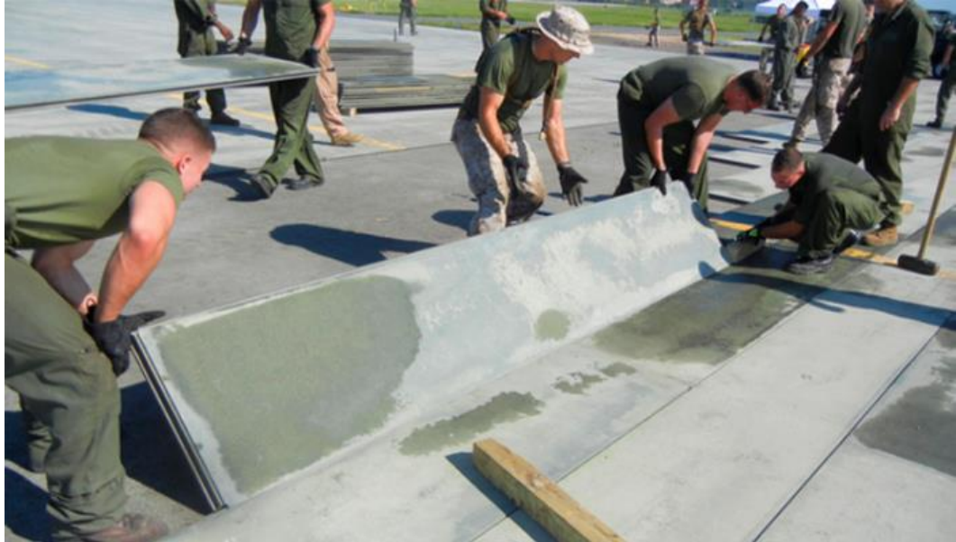
Рисунок 3.4 – Монтаж злітно-посадкової смуги
